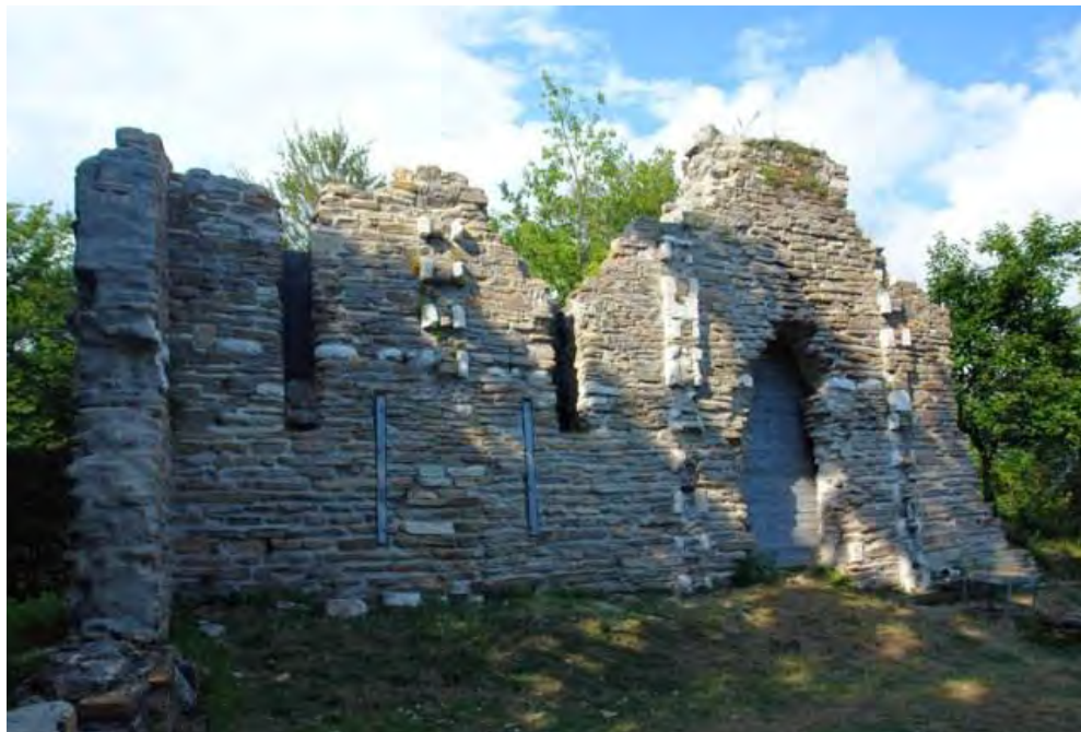
Рис. 2. Руины храма в Лоо. Современное состояние
